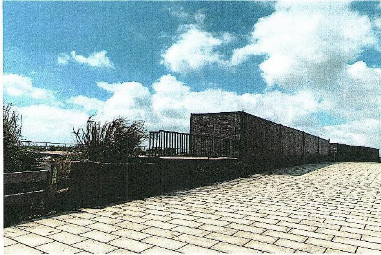
避风港大平台区块照片
